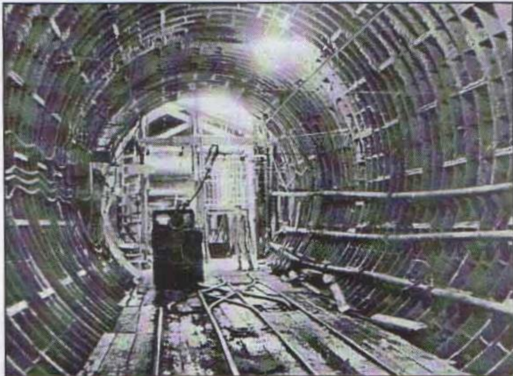
Fot. 2. Tunel \varnothing 6m zlokalizowany na wylocie „Targówek” z widokiem na szymb transportowy S-0, którym opuszczano tarczę. Rok 1956. Fot. archiwum
