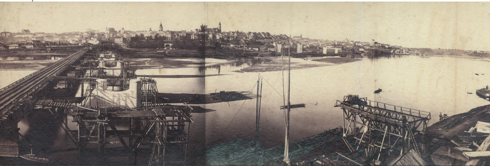
Panorama Warszawy od strony Pragi, z mostem Kierbedzia w budowie, 1863 rok
