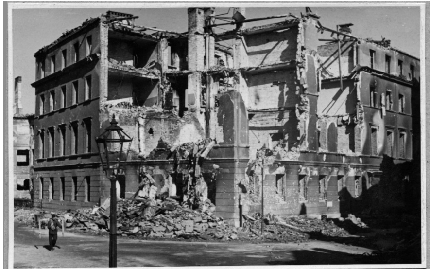
U zbiegu ul. Kilińskiego i Podwale, 1945 r.
